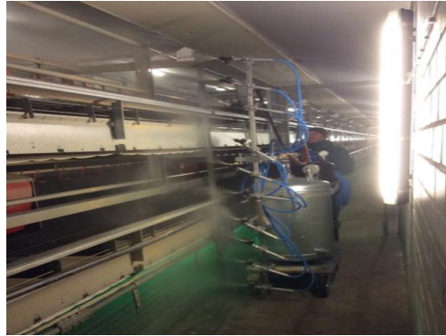
독일의 진드기예방용 실리카코팅 시공장면
