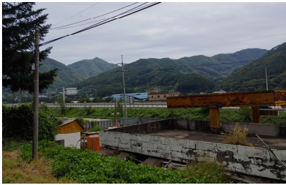
마을 내 폐건물(주유소) 및 축사(봉상2리) 자료: 연구진 촬영.
