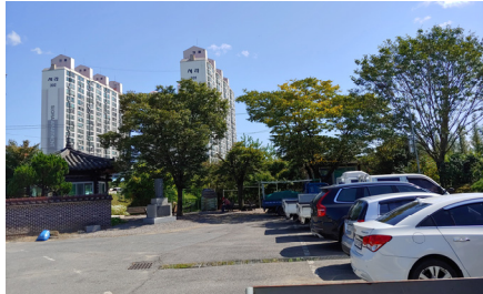
마을 주차장 및 휴게시설(벽라1리)
